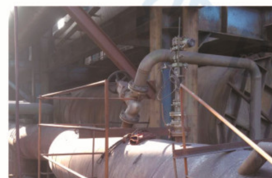
抚顺新钢有限责任公司 介质：冷风 管外径×壁厚：φ1020×10mm 压力：0.4MPa 温度：110℃
