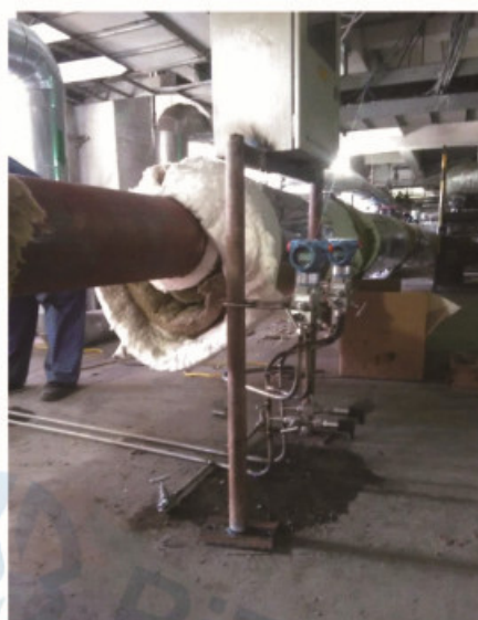
酒泉钢铁（集团）有限责任公司 能源中心一分厂 介质：双向蒸汽 管外径×壁厚：φ426×18mm 压力：1.6MPa 温度：550℃
