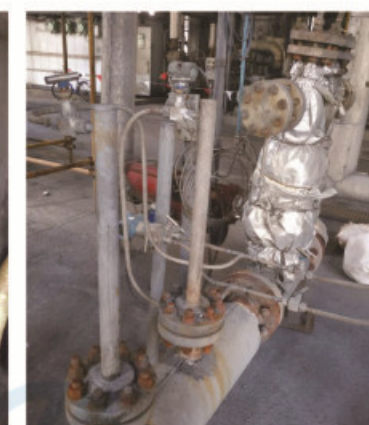
上海焦化有限公司 介质：黑水 管外径×壁厚：φ159×4.5mm 压力：4MPa 温度：115℃
